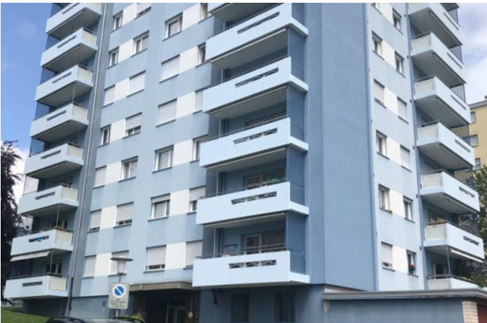
Freiburg FR, Route Joseph-Chaley 13-15 (96 Wohnungen)
