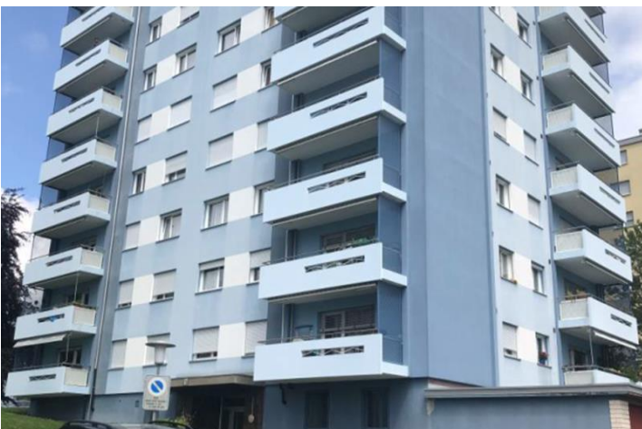
Freiburg FR, Route Joseph-Chaley 13-15 (96 Wohnungen)
