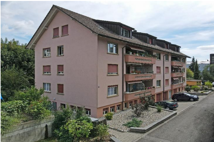
Biel BE, Bözingenstrasse 26 b+c (18 Wohnungen)
