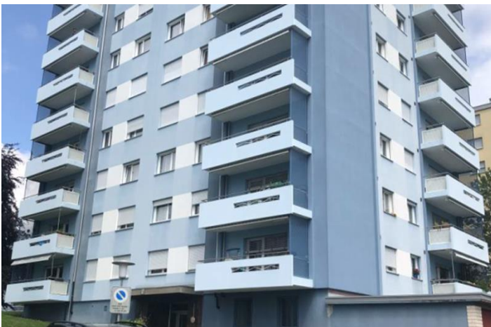
Freiburg FR, Route Joseph-Chaley 13-15 (96 Wohnungen)
