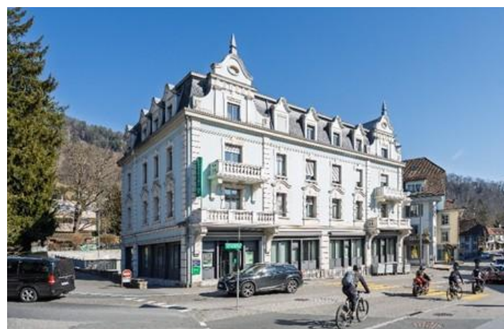
Thoune BE, Hofstettenstrasse 1
